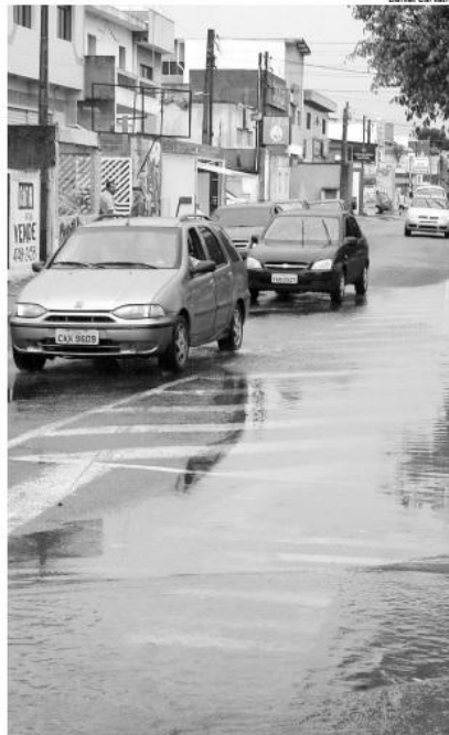
Praticamente metade do valor será para serviços de pavimentação e drenagem na rua Sete de Setembro
