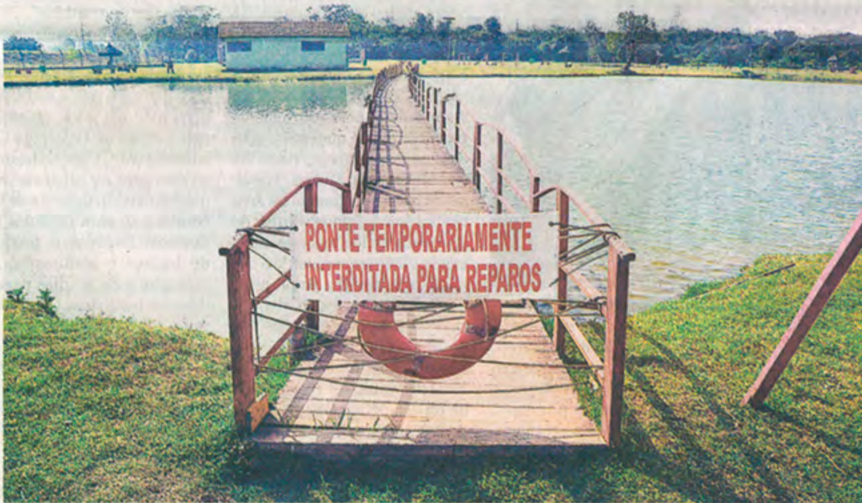
CENÁRIO Recuperação de pontes dos lagos, que foram interditas, também está prevista no projeto de revitalização
