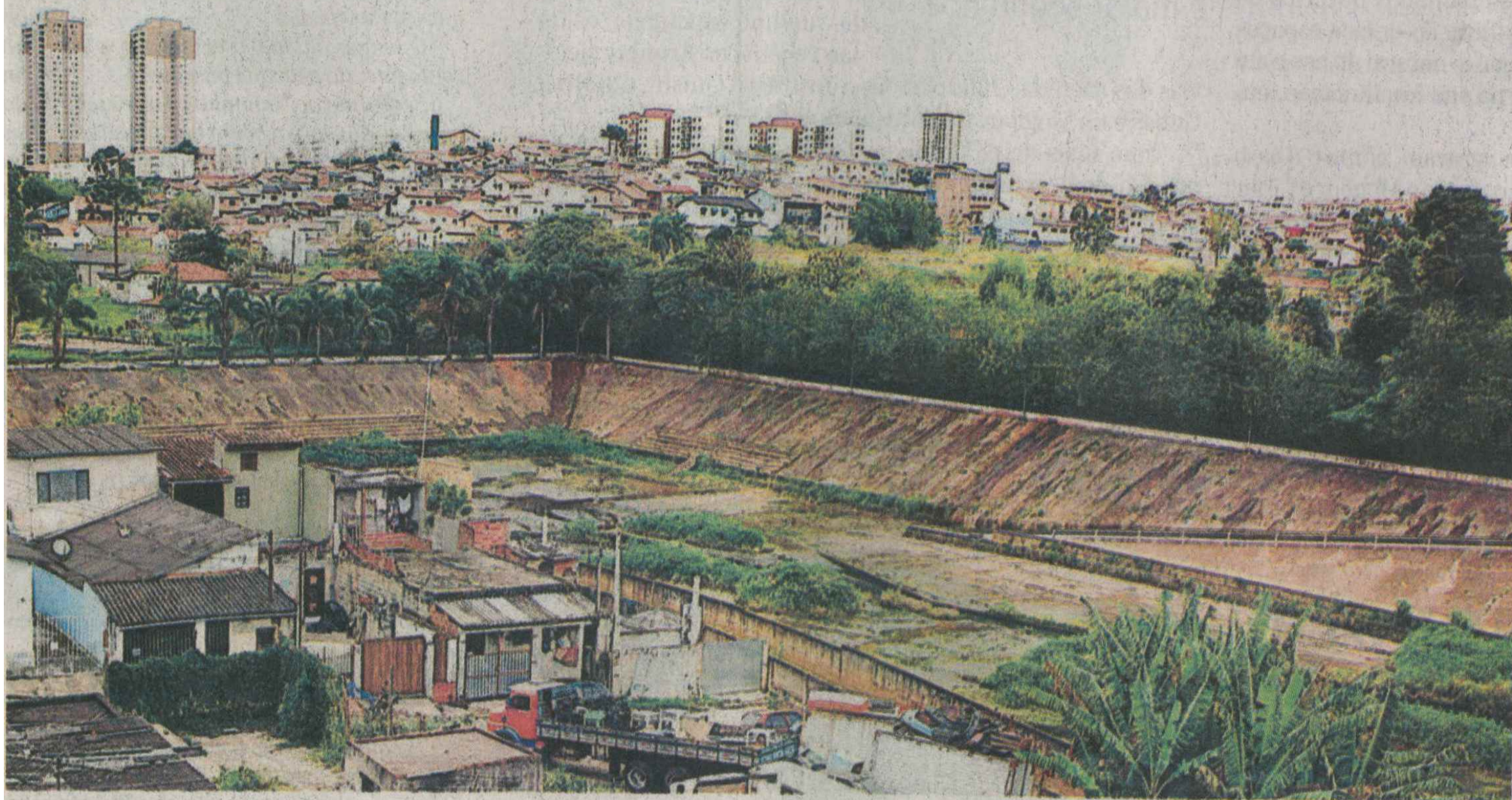
'VIZINHO INCÔMODO' Famílias que moram no entorno do piscinão do Parque Santana estão às voltas com o espaço abandonado e precário
