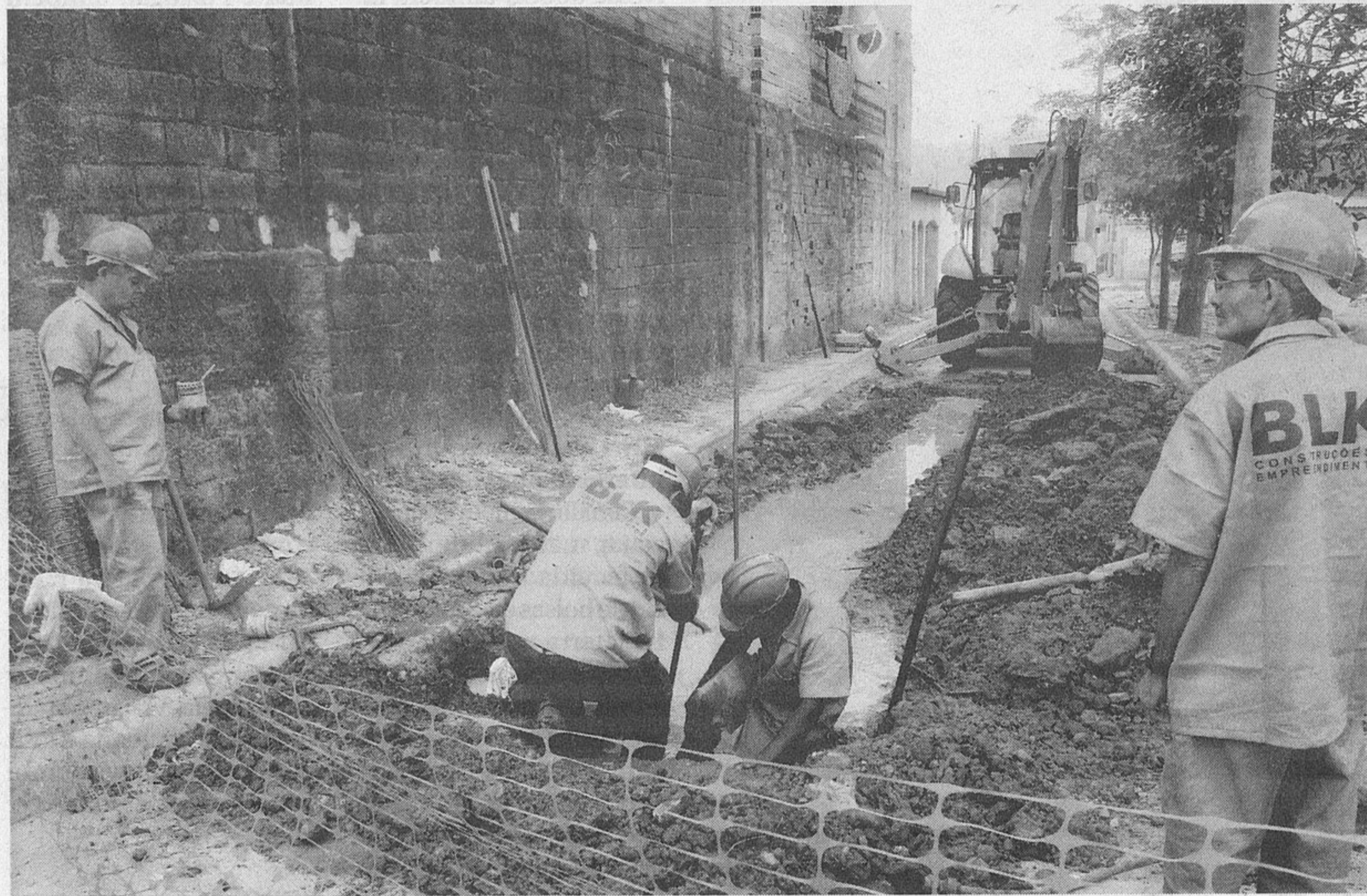
Segundo a Prefeitura, a Vila Estação foi beneficiada pelas obras com investimento de mais de R$ 8 milhões, inclusive em infraestrutura
